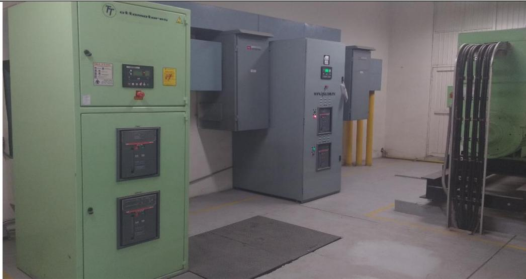
Figura 3. Tablero de transferencia 1, Tablero de transferencia 2, Planta de emergencia.
