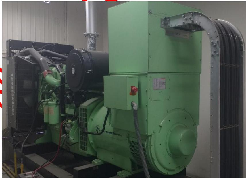
Figura 4. Planta de emergencia de 500 Kw.
