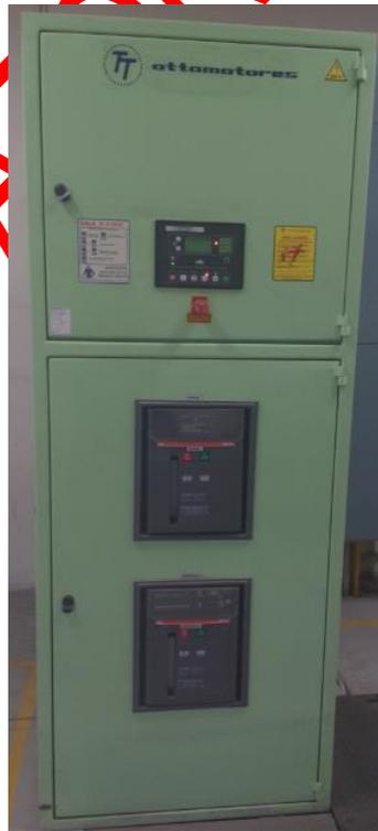
Figura 2. Tablero de Transferencia 1.
